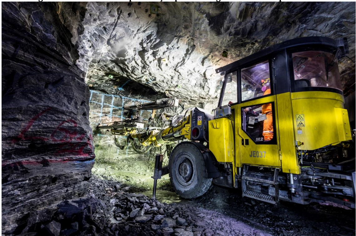
Figura 10 – Atividade de perfuração para carregamento com explosivos.
