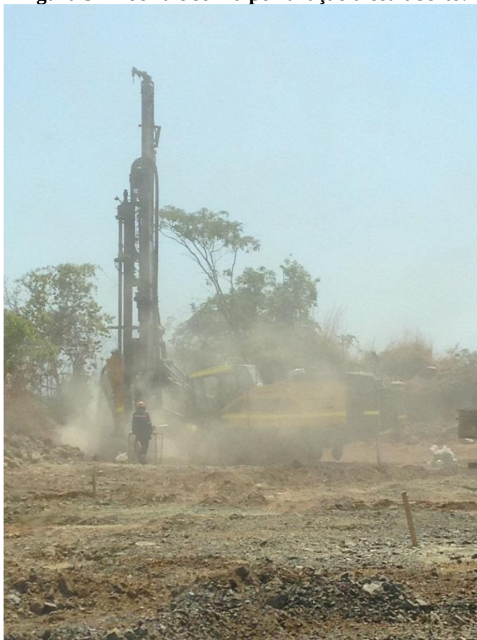
Figura 3 – Poeira e sol na perfuração a céu aberto.
