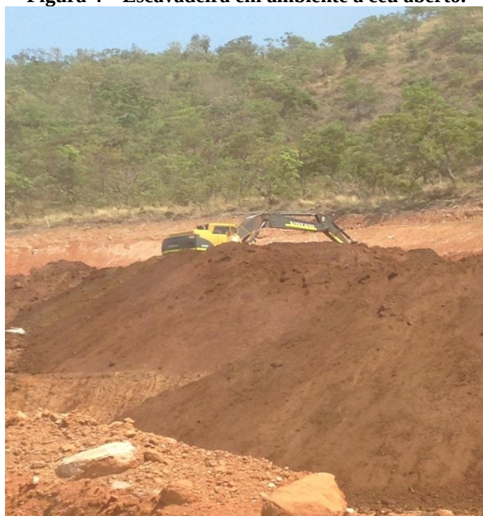
Figura 4 – Escavadeira em ambiente a céu aberto.
