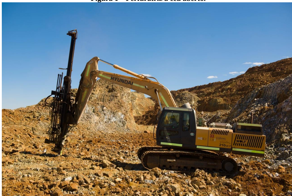
Figura 1 – Perfuratriz a céu aberto.
