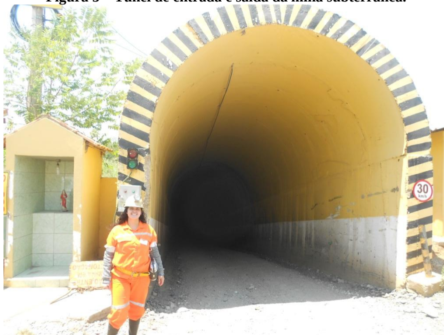
Figura 5 – Túnel de entrada e saída da mina subterrânea.
